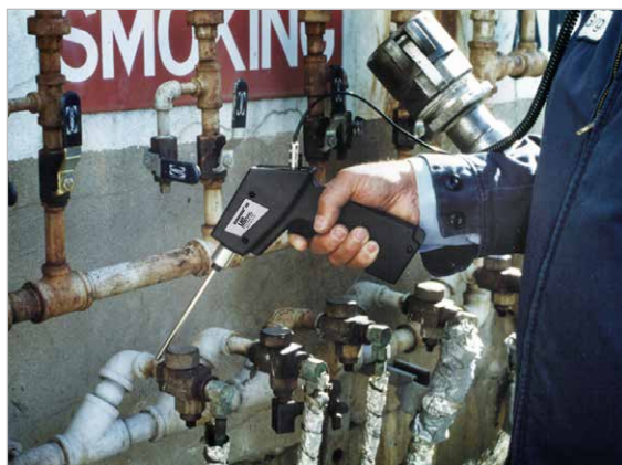
Verifica di uno scaricatore di condensa
